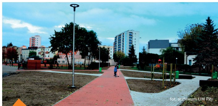
Nowy ciąg rowerowo-pieszny na połączeniu ul. Malczewskiego i Wawelskiej. Koszt inwestycji: 152.838,30 zł
